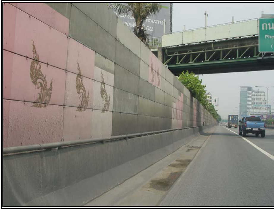
รูปที่ 3.16 กำแพงกั้นเสียงบริเวณบ้าน อ.ฉัฐอนงค์ ม่วงศรี
