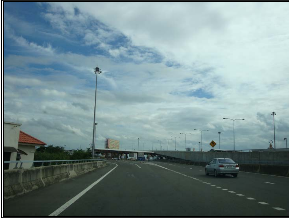
รูปที่ 3.1 ติดตั้งไฟฟ้าส่องสว่างบนแนวทางพิเศษ และติดตั้งไฟสปอตไลท์บริเวณจุดขึ้น-ลง
