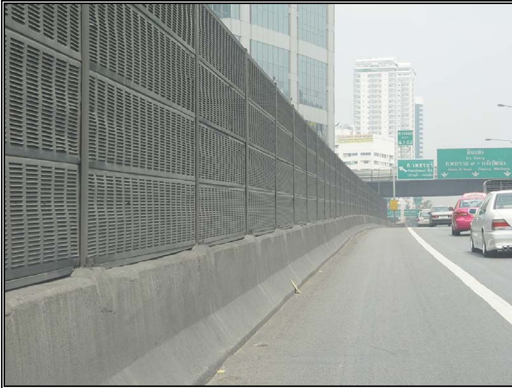
รูปที่ 3.24 กำแพงกั้นเสียงบริเวณแฟลตมาซิม
