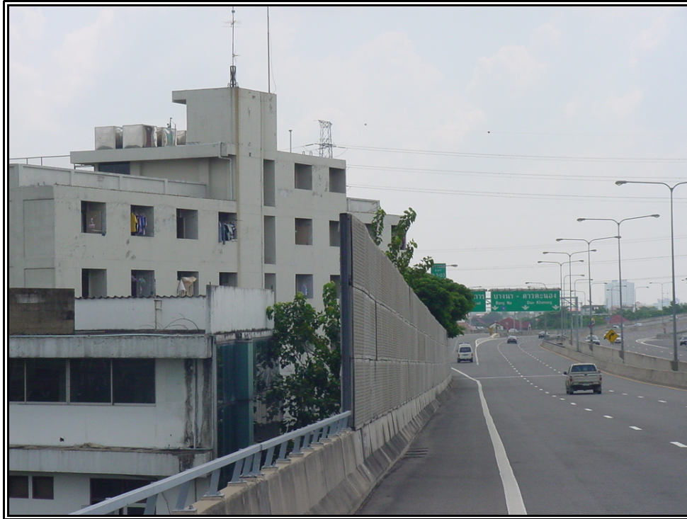
รูปที่ 3.9 กำแพงกั้นเสียงบริเวณสนามบินตราดพาร์ทเมนท์
