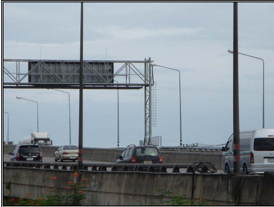
รูปที่ 3.10 ขอบ parapet ริมทางพิเศษ ความสูง 90 เซนติเมตร
