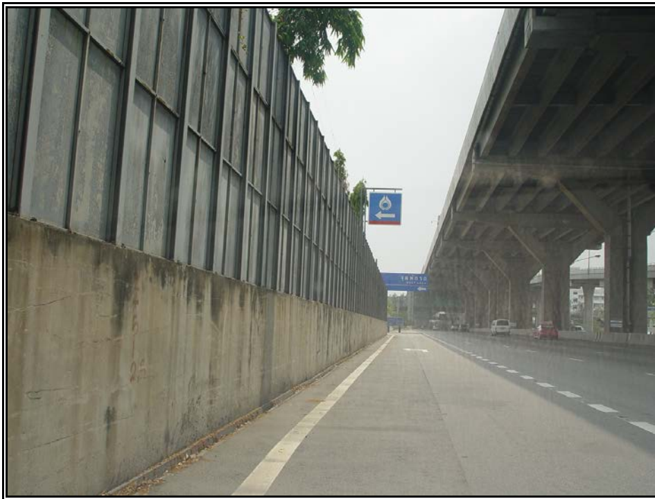
รูปที่ 3.17 กำแพงกั้นเสียงบริเวณบ้านพักข้าราชการ สนง.ปลัดกระทรวงกลาโหม
