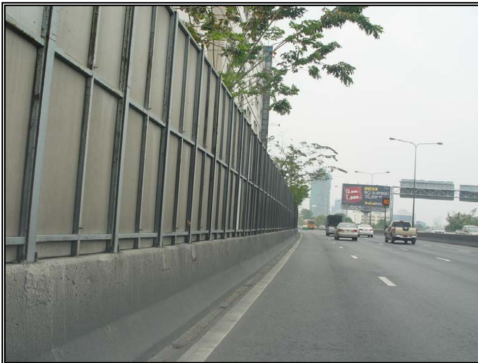
รูปที่ 3.21 กำแพงกั้นเสียงบริเวณอาคารรีเวอร์ทาวเวอร์
