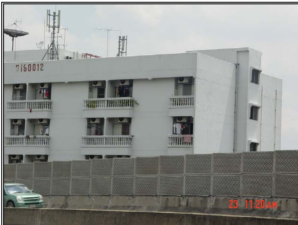
รูปที่ 3.29 กำแพงกั้นเสียงบริเวณเคที อพาร์ทเมนต์
