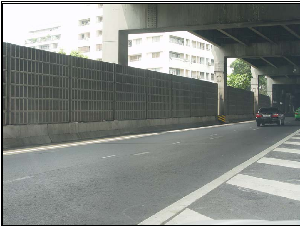
รูปที่ 3.13 กำแพงกั้นเสียงบริเวณคาร์โรลินคอร์ท
