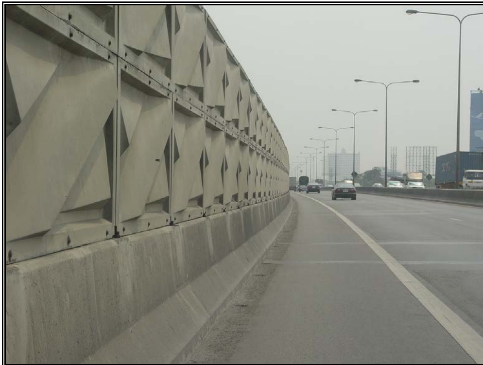
รูปที่ 3.19 กำแพงกั้นเสียงบริเวณการเคหะสุขสวัสดิ์
