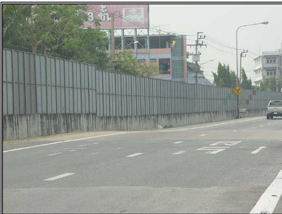
รูปที่ 3.15 กำแพงกั้นเสียงบริเวณบ้านนายศิลปินชัย นิดโนรี
