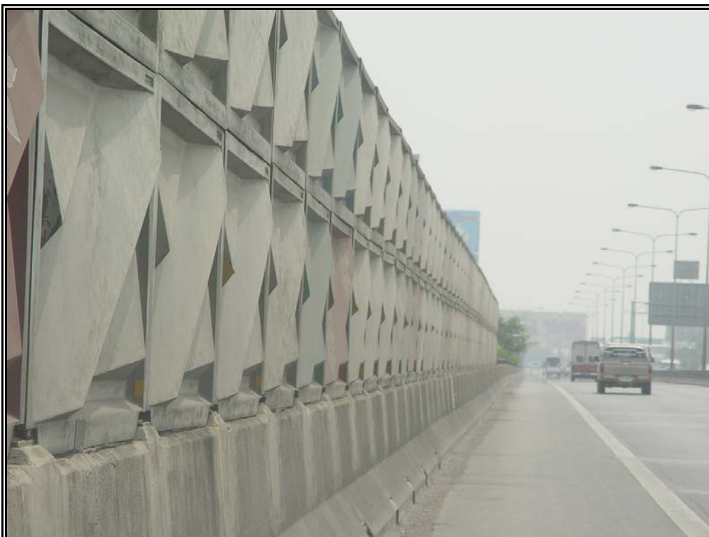
รูปที่ 3.25 กำแพงกั้นเสียงบริเวณนั้ตริวิมล แมนชั่น
